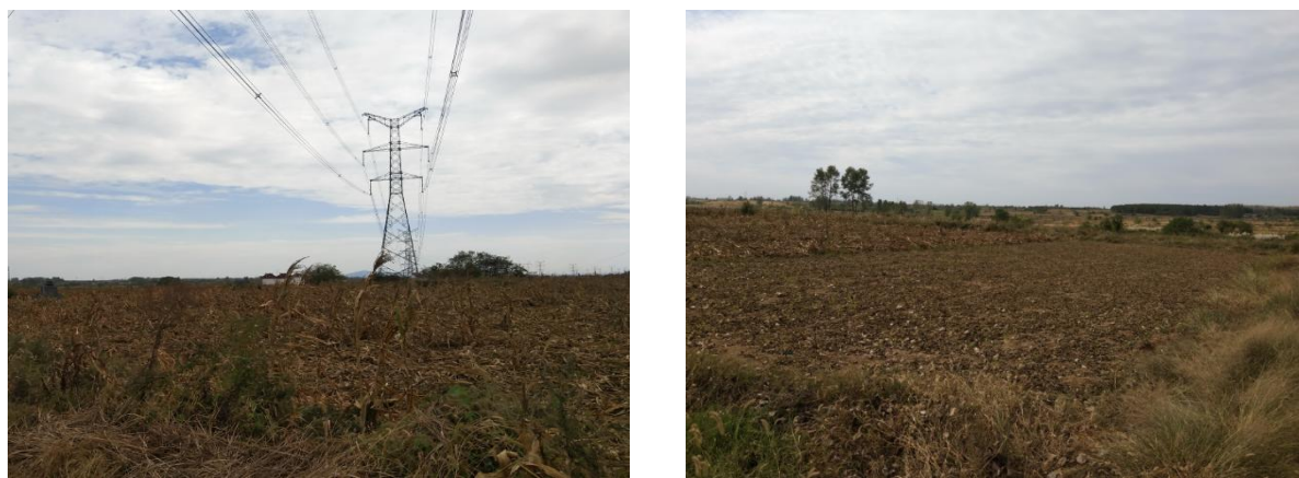
新建 500kV 输电线路沿线地貌
